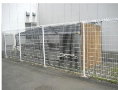
内視鏡・MRI室室外機（架台を組んで）
