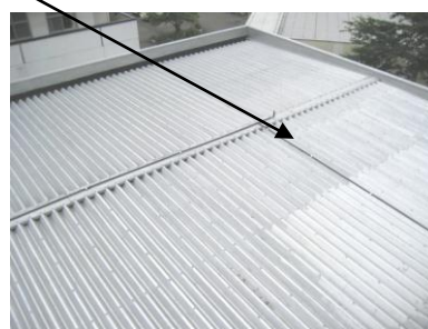
本部棟2階屋上・4階「未来」屋上
